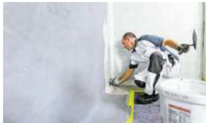
Mit der ISOTEC-Innenabdichtung wird der Keller nicht nur abgedichtet, sondern gleichzeitig auch optisch aufgewertet.
