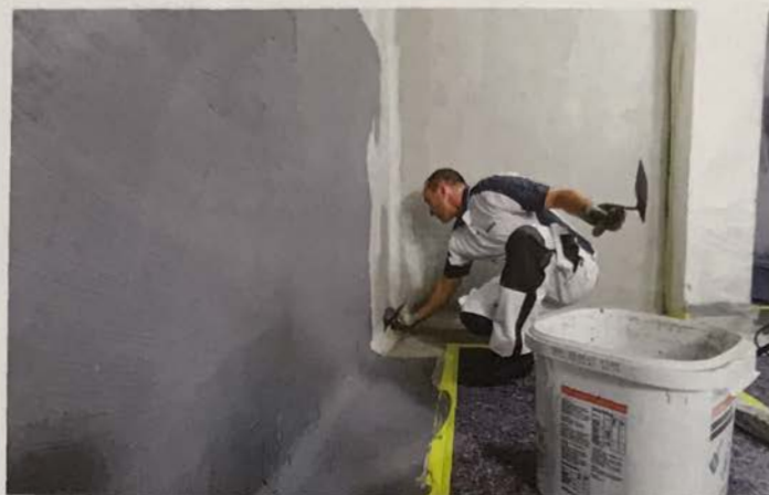
Mit der ISOTEC-Innenabdichtung wird nicht nur der Keller abgedichtet, sondern auch optisch aufgewertet.
