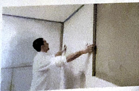
Die ISOTEC-Klimaplatte ist in der Lage, pro Quadratmeter literweise Wasser aufzunehmen.
