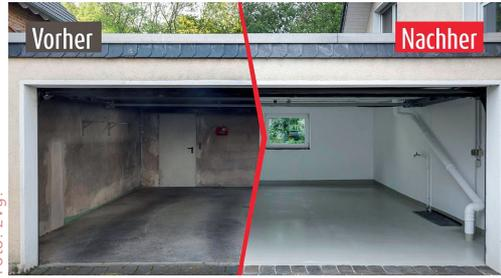
dere mehr verschmutzen den Boden über Jahre. Der Überzug wird mit der Zeit fleckig und bröselig. Denn in Kombination mit Rissen, die durch die Dauerbelastung in der Oberfläche entstehen, wird der Garagenboden auch durchfeuchtet und lässt sich nicht mehr reinigen. Da nützt auch Farbe nichts, mit der manche den Garagenboden streichen.
