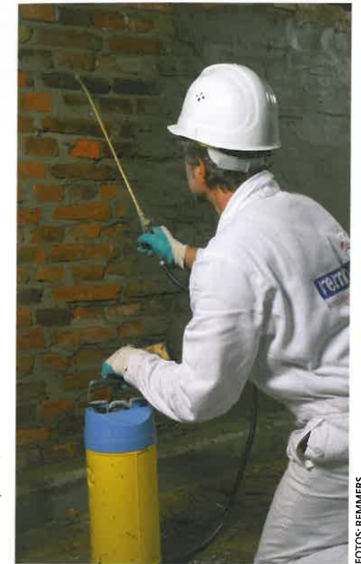
Bauwerksabdichtung: Grundierung des vorbereiteten Untergrunds mit Kiesol.
