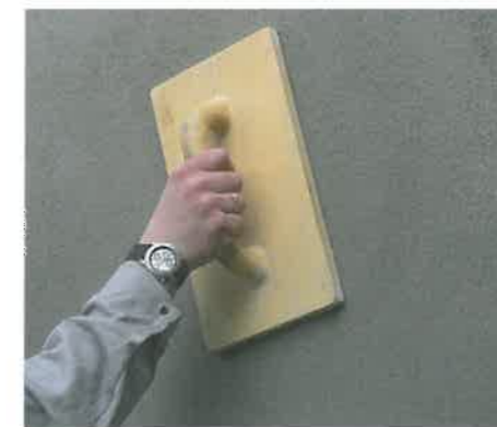
Sanierung von feuchtigkeits- und salzbelasteten Untergründen: Auftrag eines Sanierputzes
