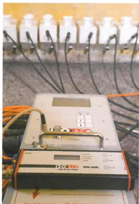
Vor dem Einfüllen von Paraffin: Trocknung eines Wandabschnitts mittels Heizstäben und Temperaturregelgerät
