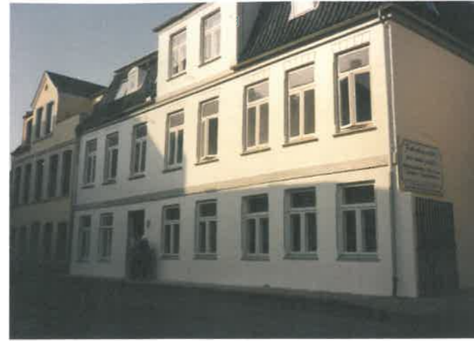
Nachher: Nach dem Auftrag des Sanierputzes erstrahlt das Gebäude in neuem Glanz.
