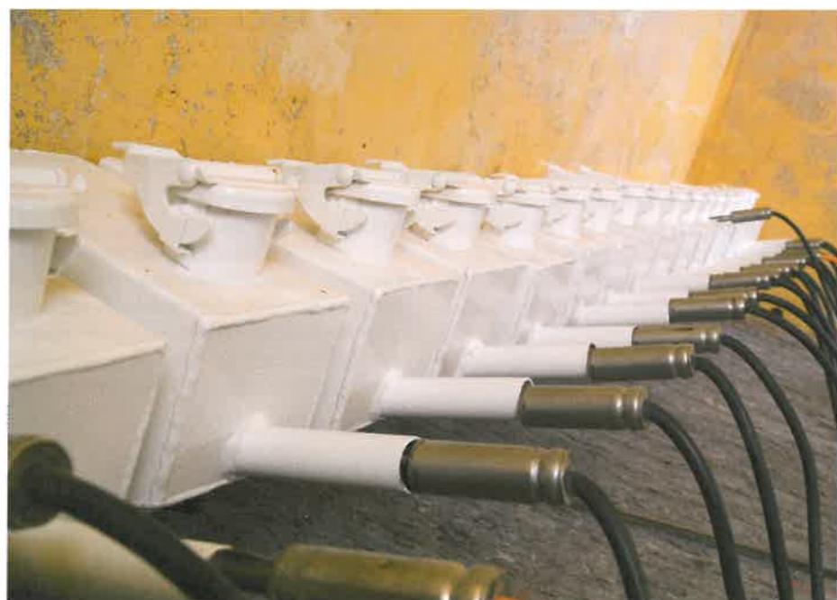
Heizstäbe und Paraffinbehälter, durch die später das erhitzte Paraffin in den Wandabschnitt nachfließt
