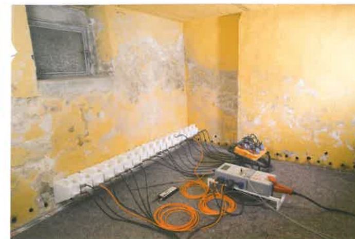
Bei dem Paraffin-Verfahren von Isotec wird zunächst die betroffene Mauer vollständig austrocknet und erst dann gegen kapillare Feuchtigkeit versiegelt.
