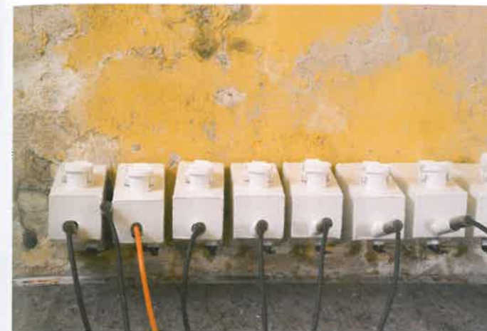
Injektionsverfahren: Die „Isotec“-Horizontalbarriere stoppt aufsteigende Feuchtigkeit.
