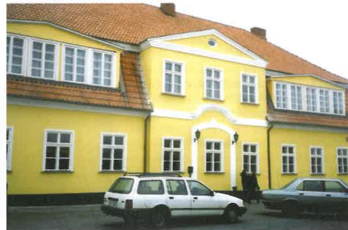
Nachher: Nach dem Auftrag des Sanierputzes erstrahlt das Gebäude im neuen Glanz.
