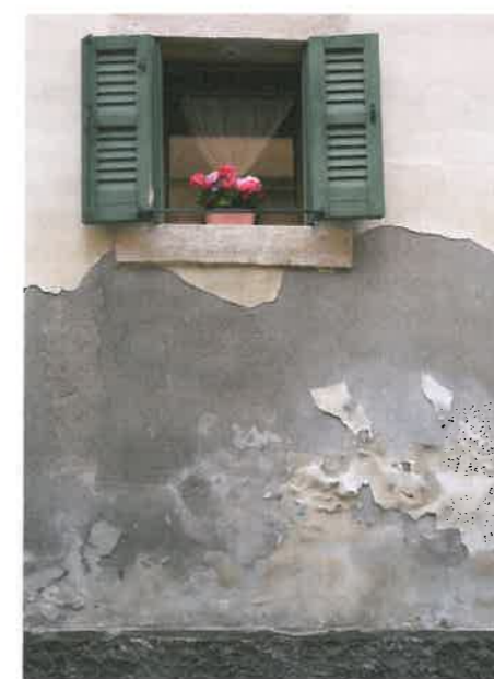
So kann sich Feuchtigkeit sichtbar machen. Um wirklich sinnvoll und nachhaltig zu sanieren, muss die Ursache ermittelt werden.
