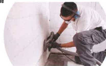
Hier stemmt der Handwerker eine Nut aus, um die vorhandene Horizontalsperrbahn in die Isotec-Innenabdichtung integrieren zu können.
