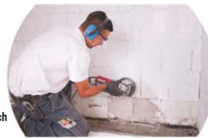
Zuerst wurde ein 30 Zentimeter breiter Estrichstreifen entfernt, um die Wandflächenabdichtung wasserdicht an die Betonbodenplatte anschließen zu können.
