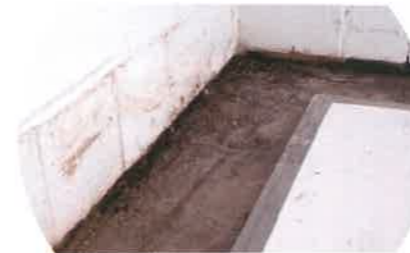
Zuerst wurde ein 30 Zentimeter breiter Estrichstreifen entfernt, um die Wandflächenabdichtung wasserdicht an die Betonbodenplatte anschließen zu können.
