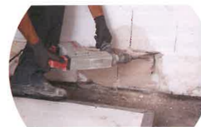
Hier stemmt der Handwerker eine Nut aus, um die vorhandene Horizontalsperrbahn in die Isotec-Innenabdichtung integrieren zu können.
