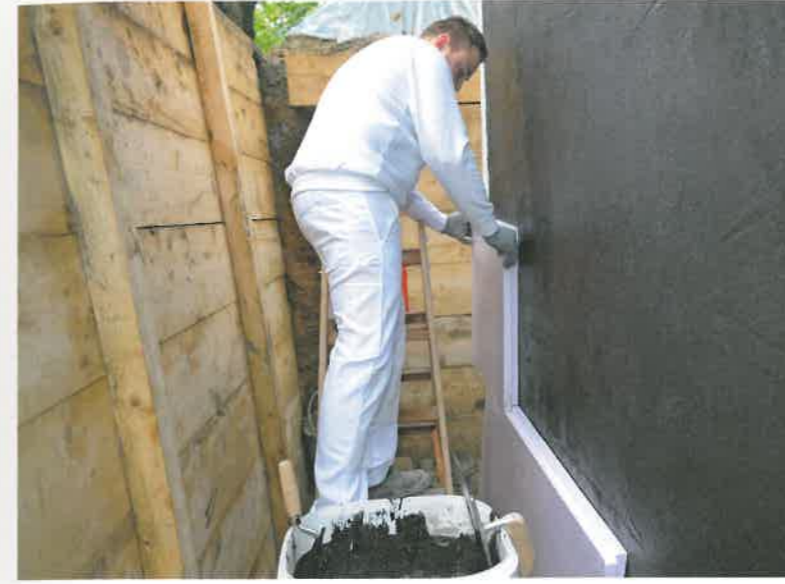
Auf die Bitumendickbeschichtung kamen Polystyrolplatten, um die Abdichtungsbeschichtung vor mechanischer Beschädigung zu schützen.
