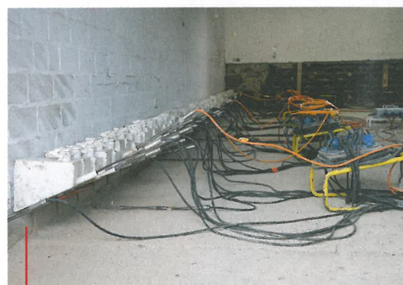
Horizontalsperre gegen aufsteigendes Wasser: Heißes Paraffin wird in die zuvor getrocknete Wand injiziert. Isotec
