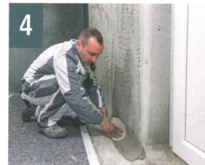
4 Wand-Sohlenanschluss: Mit einer Hohlkehle wird der Dichtspachtel aufgetragen.
