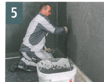
5 Im Spachtelverfahren kommt die zweite Lage Abdichtungsmaterial auf die Wand.
