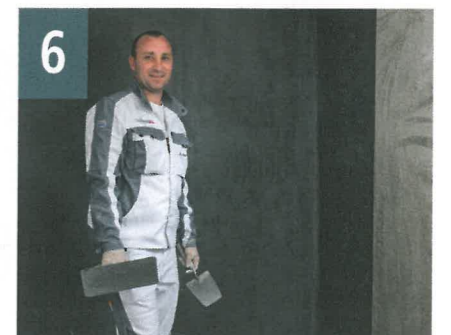
6 Die fast komplett bearbeitete Wand ist nach Abschluss der Arbeiten von innen trocken.
