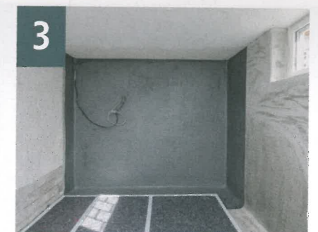
3 Auf der Wand vor Kopf wurde das Abdichtungsmaterial bereits aufgetragen.
