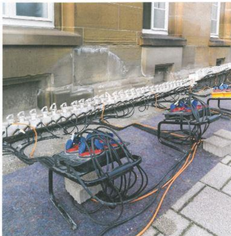
Ins feuchtebelastete Mauerwerk wird die Horizontalsperre mit erhitztem Spezialparaffin gelegt.
